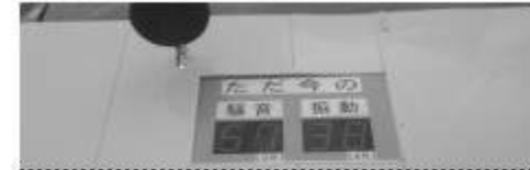
↑工事現場の2か所に設置された騒音・振動の表示板。写真は北側(二小側)の壁に取り付けられたもの。
