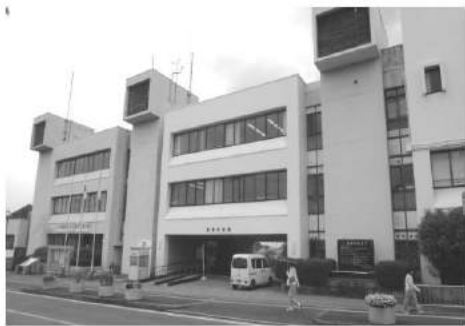
耐震工事が未だの役場庁舎
