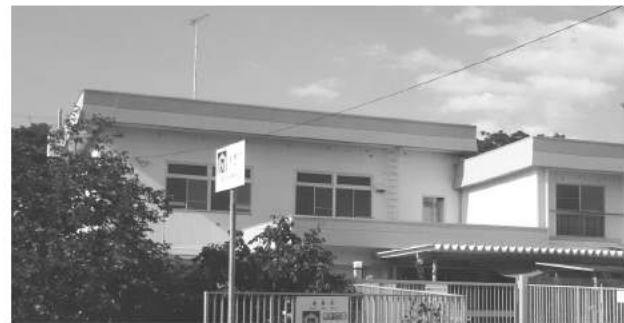
写真は、耐震化未実施の第四保育所
