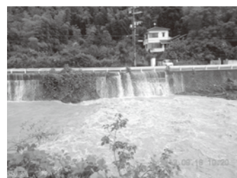
緊急土砂置き場から水無瀬川の流れ込む雨水
